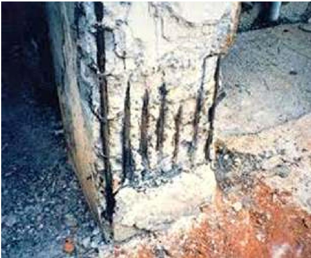
Em resumo, a corrosão das armaduras em estruturas de concreto é considerada uma anomalia grave com consequências que podem levar ao colapso estrutural, com desabamentos de edifícios, marquises, pontes, entre outros. Após iniciada, caso não haja intervenções de tratamentos adequados e recuperações, a corrosão adquire uma constante de progressão ininterrupta em praticamente 100% dos casos.
